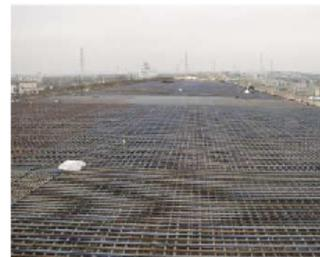
・型枠組立後、鉄筋・PC鋼材を配置し、コンクリート打設に移ります。
