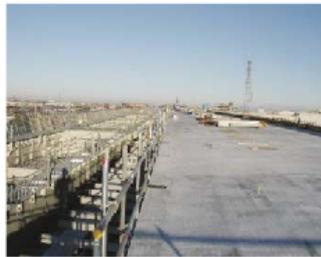
・コンクリートを打設/養生の後、PC鋼材を緊張して、PC床版の完成です。
