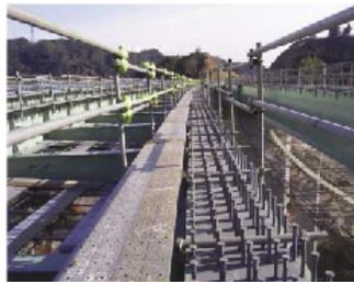
・床版施工前は、主桁上に安全通路が改修されています。
