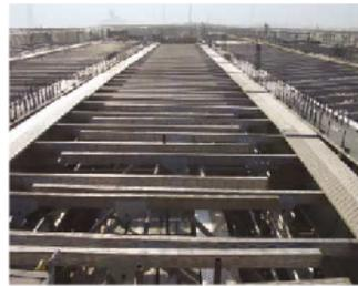
・主桁を利用して、コンクリートを支持する支保工を設置します。
