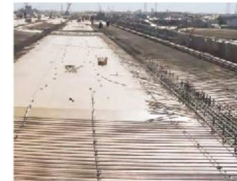
・下筋、PC鋼筋、上筋の順に組立てます。
